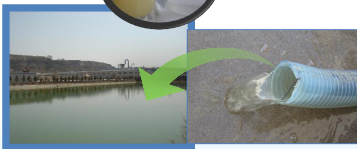
提取回收蛋白后废水再经过保温固定化曝气生化池处理后其COD值降到100以下，可以养鱼或农田灌溉
